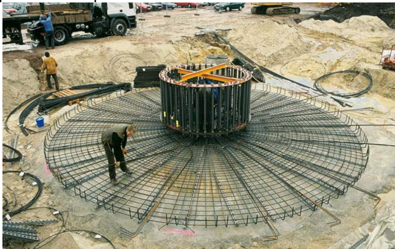
Slika– Izgradnja temelja vetrogeneratora
